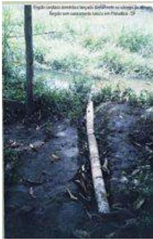
**Figura 10.** Encanamento Destinando Efluentes Sanitários para o Córrego do Atoleiro. Fonte: Oliveira (2013)
