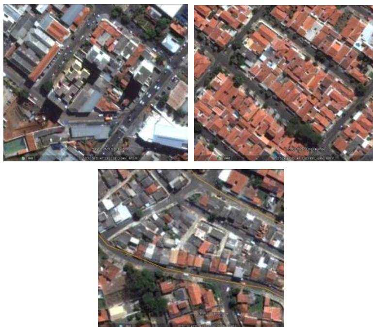
Figura 12 . Tipos morfológico distintos por característic de ocupação de quada: quadras mistas, edificações térreas em lotes medianos e quadras em processo de ocupação com ocupação de espaços livres intra-quadras. Fonte: Silva e Lima ( 2014).
