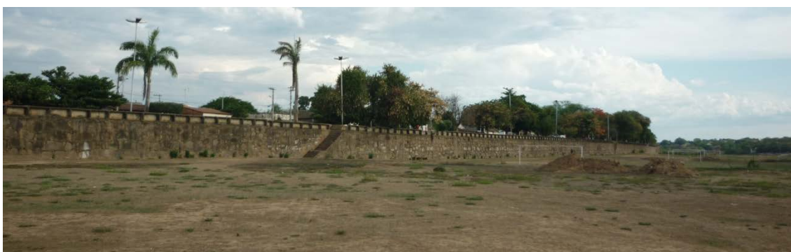
Figura 21. Área de borda retificada, compreendida entre a ponte Marechal Hermes de Paula e o porto fluvial. Fonte: Arquivo do autor.
