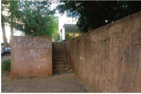
Foto 1. Muro de contenção
