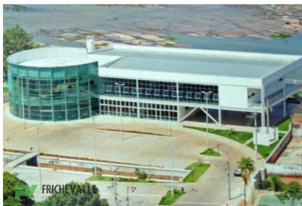
Figura 22. Centro de Convenções de Pirapora. Fonte: http://www.frichevalle.com.br/publicas.php . acesso em: 16 nov 2014
